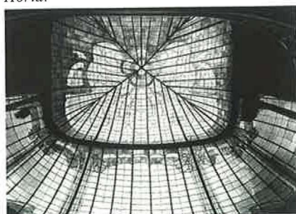
VERRIÈRE COIFFANT L'ESCALIER PRINCIPAL DE L'HÔTEL AUBECQ, 520 AVENUE LOUISE À BRUXELLES. 1899 - 1902.
